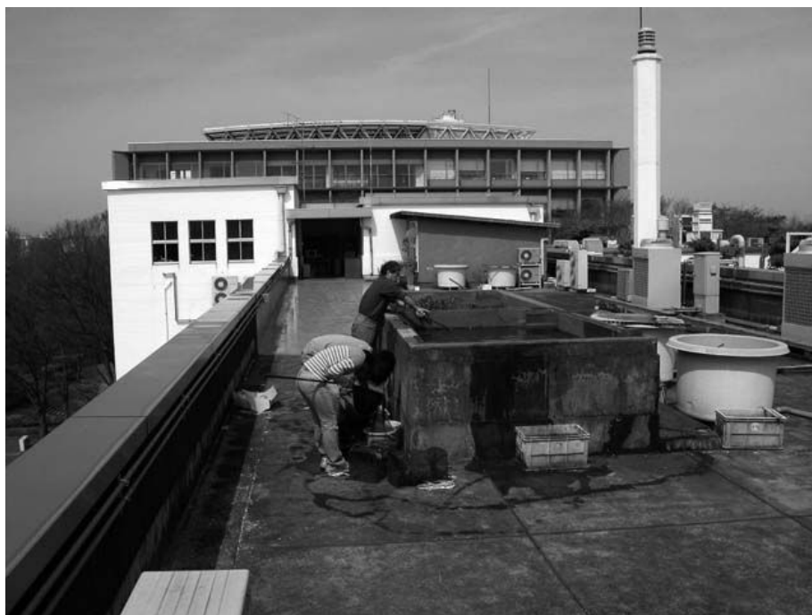
写真 4－2－10 校舎屋上の水槽
