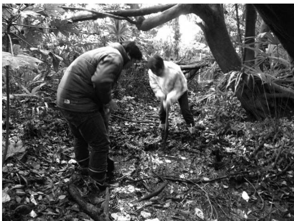
写真 4-2-16 池の造成工事
