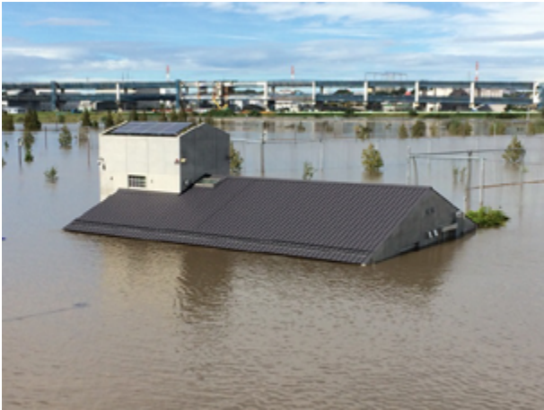
昨年10月、鶴見川流域を襲った狩野川台風に続く規模の台風18号。鶴見川多目的遊水地が一時水を溜め、下流を水害からまもった。
