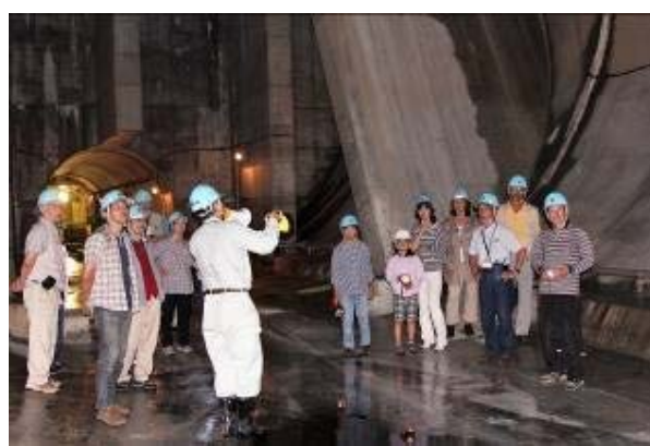
地下25m・直径16m 長さ600mの貯水トンネル
