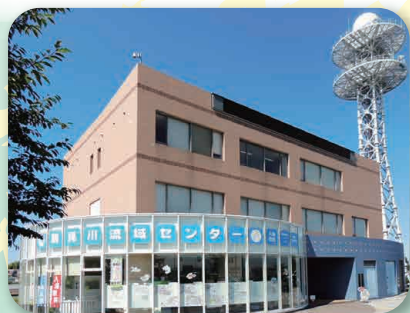
地域防災施設 鶴見川流域センター
