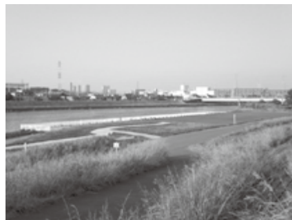
駒岡防災船着場
